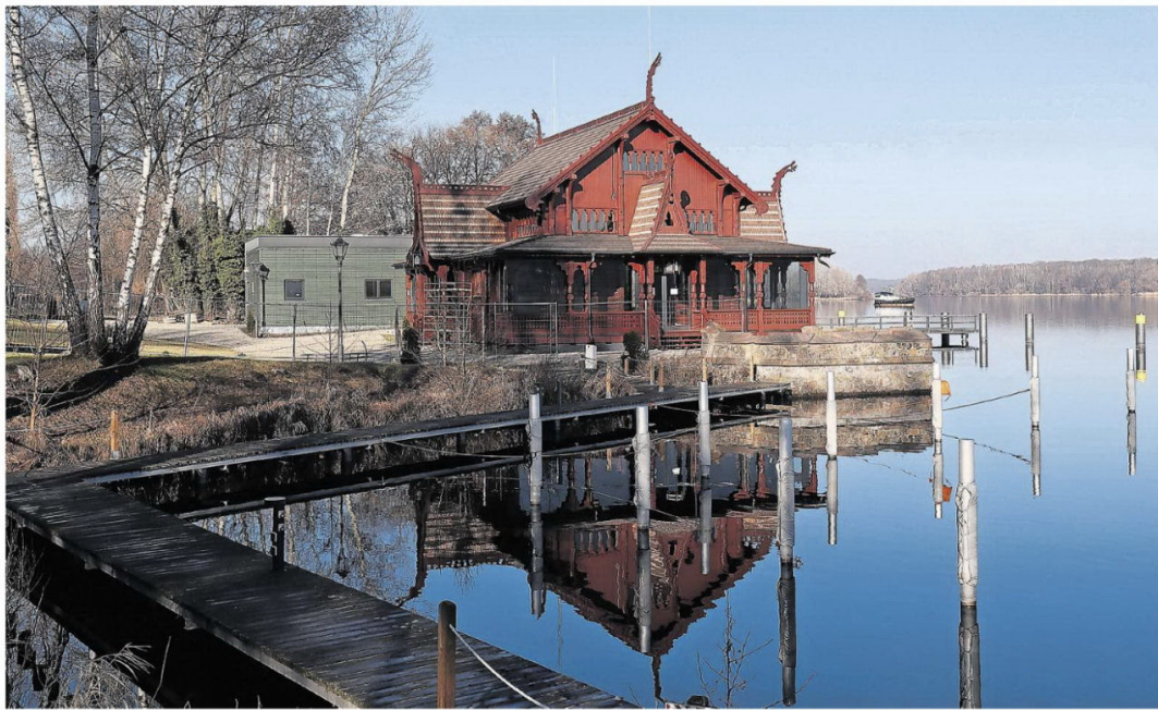
Nordisches Flair. 98 Prozent der Ventehalle und des modernen Neubaus am Jungferensee sind nach Angaben des Eigentümers mittlerweile fertig. Die Speisekarte des neuen, noch nicht öffentlich bekannten Pächters soll das Thema Norwegen und die Wassernähe aufgreifen. Fotos: Ottmar Winter (2), Andreas Klaus
