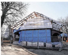
Eingerüstet. Auch die Norwegehäuser will Investor Michael Linckersdorff herrichten.
