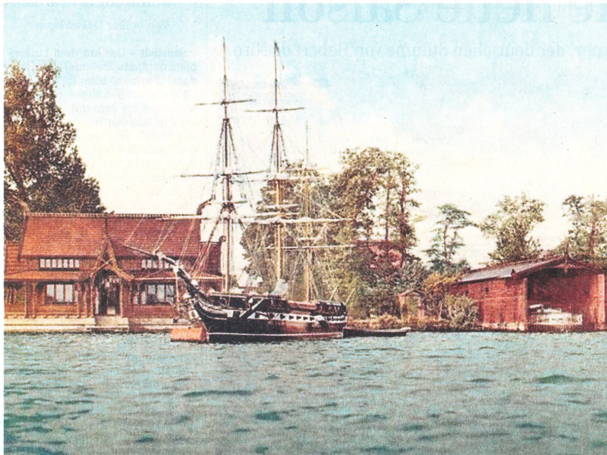
Ansicht der Matrosenstation mit Ventehalle, „Royal Louise“ und Bootsschuppen um 1900.
