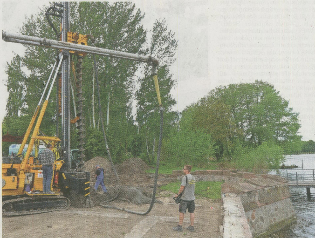
Dieser Bohrer trieb gestern die ersten Löcher für Betonpfähle ins Erdreich.
