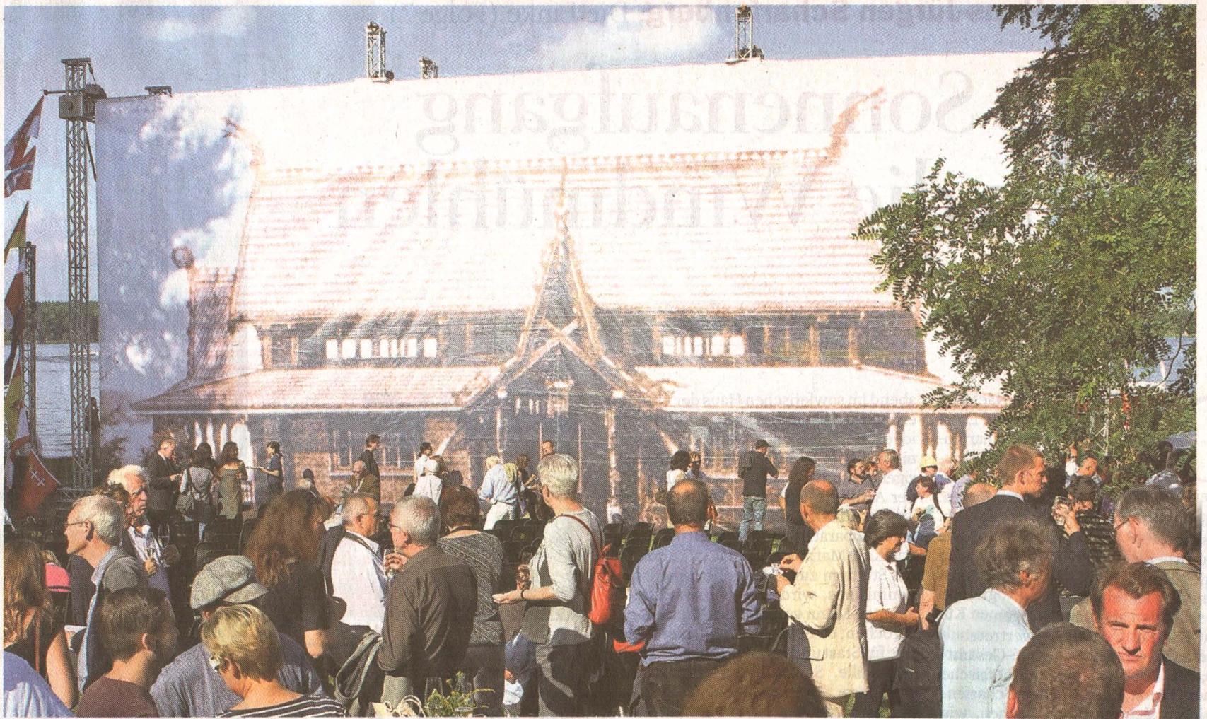
Ein großes Poster der historischen Ventehalle wurde auf dem Bauplatz der neuen Ventehalle aufgezogen.
