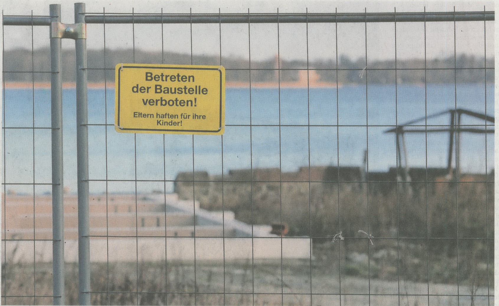
Warten auf Kongsnæs. Das Fundament – hier links im Bild – steht schon seit einigen Monaten. Die Ventehalle selbst soll nach derzeitiger Planung im Sommer kommen. Investor Michael Linckersdorff will sie dann als Restaurant verpachten – gegen den Willen einiger Anwohner.
