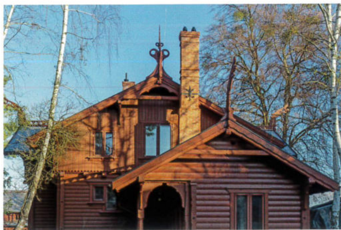
Das Kapitänshaus von Süden mit dem überdachten Wohnungseingang des Kapitäns zu seiner Obergeschosswohnung.
