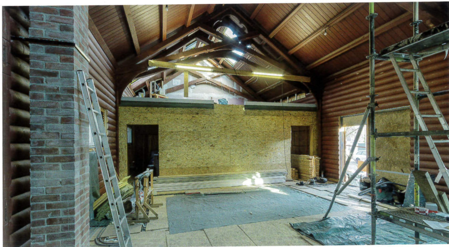
Blick in die noch in der Wiederherstellung und dem Umbau befindliche ehemaligen Bootshalle.
